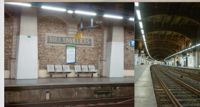
De haut en bas et de gauche à droite: le site de la station Boulaivilliers a été recouvert d'une dalle de béton, dans le cadre du projet VMI (Voie de Montmorency - Invalides). L'ancienne passerelle d'accès aux quais sort aujourd'hui d'abri; la gare a conservé une partie des installations d'origine, comme ici la plaque indiquant le nom de la station; une vue des quais sous dalle (photos du 6 juillet 2012).
