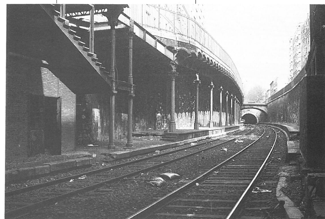
(Ci-dessus) La Petite Ceinture sud en février 1988 : la voie intérieure a été remise en état en 1964 avec équipement en rails Vignole ; les rails Double Champignon de la voie extérieure sont déposés, et seules subsistent les traverses, encore armées de coussinets. (Cliché T. Joussant)
