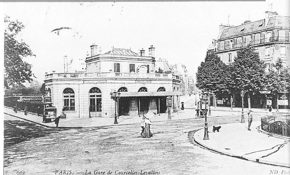
La gare de Courcelles-Levallois, située sur le tronc commun à 4 voies de la ligne d'Auteuil et de la Petite Ceinture. (Coll. CDR)
