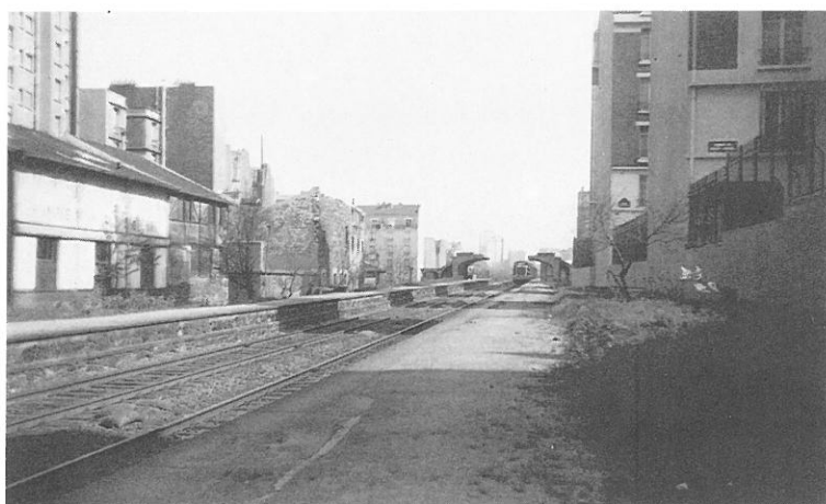
La station Claude Decaen, dont on aperçoit au fond les abris de quai en béton armé, fut réaménagée en 1931 pour desservir l'Exposition Coloniale. (Cliché R. Eschenbrenner)
