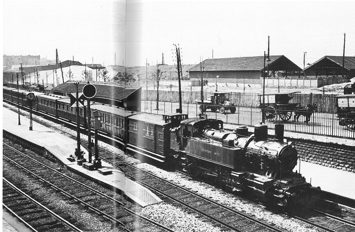
La Chapelle St Denis : train circulaire extérieur remorqué par la 230 T n°57. Les deux voies à gauche correspondent au raccordement des Poissonniers avec la Gare du Nord. (Cliché Bègue)
