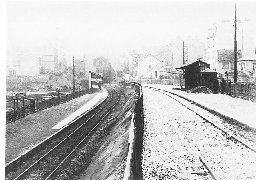
La gare de Charonne-Voyageurs durant les travaux de suppression des passages à niveau. A droite, la nouvelle voie établie en remblai. (Coll. et cliché ENCP Paris)
