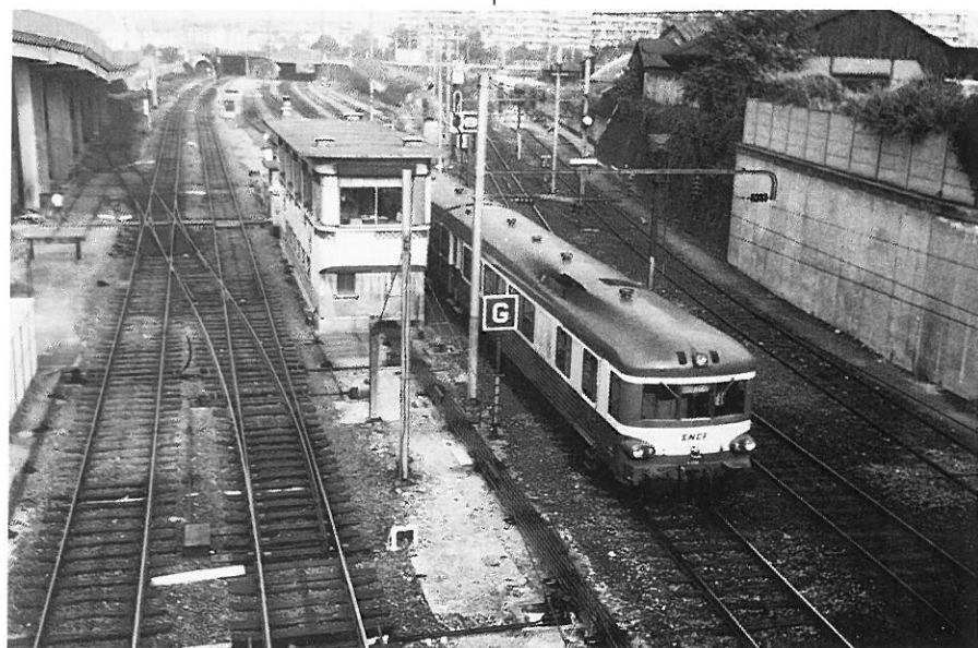
L'Évangile : au premier plan à gauche, la double voie de la Petite Ceinture vue ici en direction de l'est ; à droite, le raccordement avec les voies de Paris-Est. (Cliché T. Joussant)
