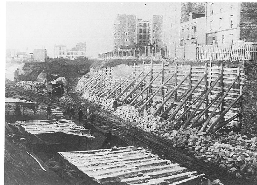
Travaux de mise en tranchée du raccordement des Epinettes, vers le fond du cliché. A gauche, direction de la Porte de Clichy ; à droite, l'avenue de St Ouen. (Coll. et cliché ENPC Paris)
