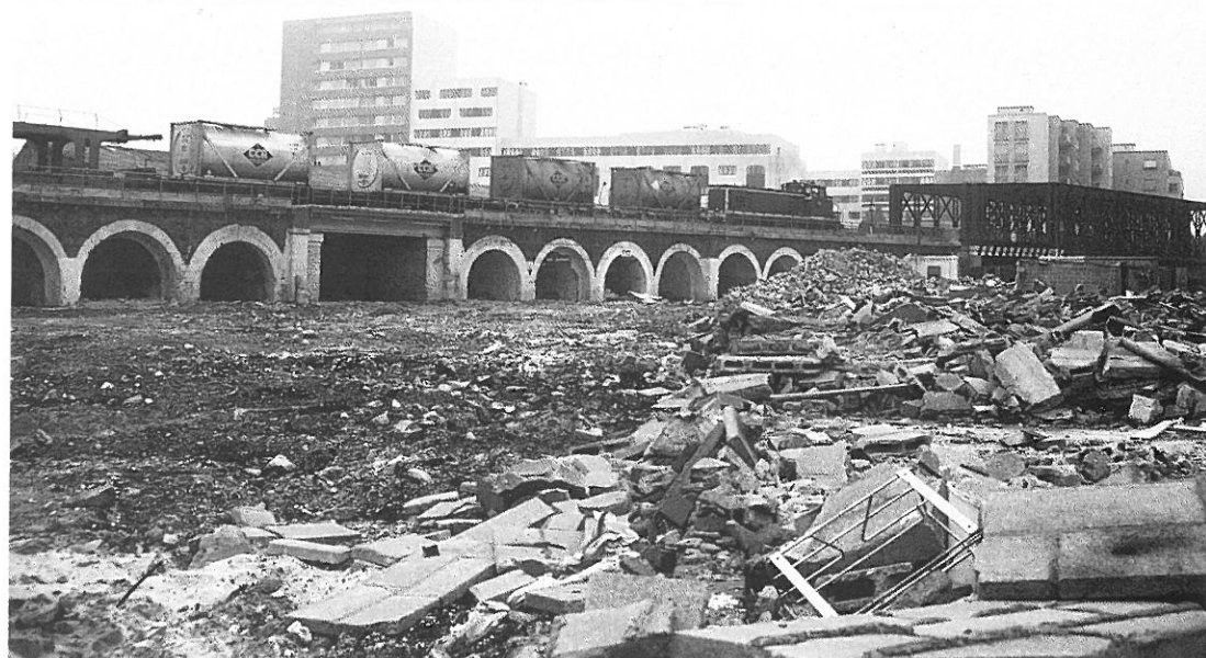
Entre le canal St Martin et le Pont de Flandre, la Petite Ceinture est établie sur un viaduc en maçonnerie. Les friches industrielles vont céder la place à de nouveaux immeubles d'habitation ou de bureaux. (Cliché MF Frachot)
