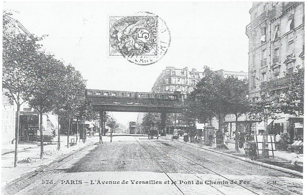
A la sortie de la station aérienne du Point du Jour, les voies de la Ceinture franchissent l'avenue de Versailles. Au premier plan, les voies du tramway Louvre - Versailles, dont on aperçoit au fond du cliché une motrice Five-Lille, remorquée par une locomotive Purrey en attendant l'électrification. (Coll. Rigouard)
