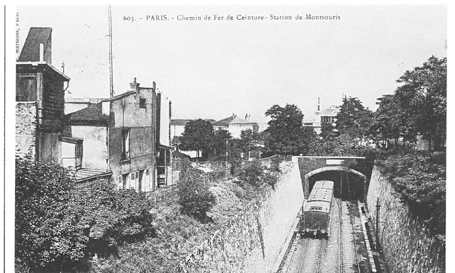
Vers 1905, un train circulant sur la voie intérieure vient de sortir du tunnel de Montsouris et passe sous le pont de la rue de l'Amiral Mouchez avant d'entrer dans la station du Parc de Montsouris dont le BV est caché par le feuillage. Une voiture de 1 re (comportant en toiture 5 fois deux couvercles de lampes) est placée devant le fourgon. (Coll. A. Jacquot)
