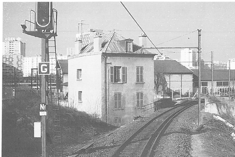
Suite au réaménagement du quartier, le raccordement de Tolbiac, à voie unique électrifiée en continu 1,5 kV, est appelé à disparaître au profit du rétablissement du raccordement d'Ivry, orienté vers la banlieue. (Cliché A. Bommart)
