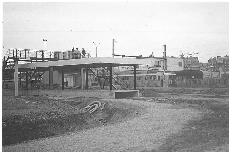
Boulevard Victor : sur le site de l'ancienne gare de Grenelle-Marchandises a été installé en 1986 le Centre d'Expérimentation Technique du système ARAMIS. Au premier plan, la plate-forme de la piste d'essais ; au fond, le quai voyageurs ARAMIS, établi parallèlement à celui de la ligne C du RER, dont on aperçoit une rame Z 5100. (Cliché PL)
