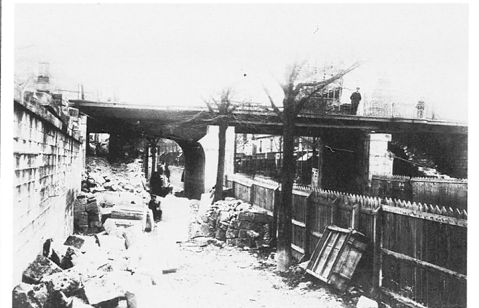
Construction du raccordement direct des Batignolles, qui va boucler la Petite Ceinture.
