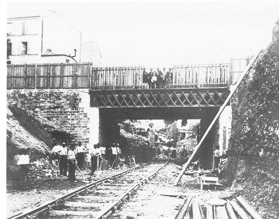
Sur le «Chemin de fer de Rive Droite», travaux de suppression des passages à niveau avec l'avenue de St Ouen.
