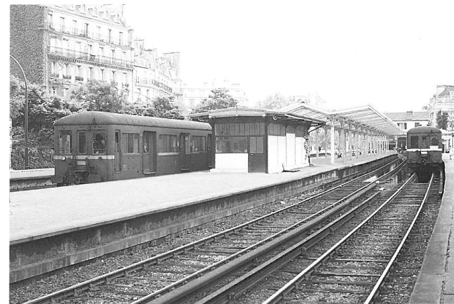
Rames Standard en gare d'Auteuil. C'est ce matériel moderne (pour l'époque) qui sera à l'origine de la longévité de la desserte de la ligne d'Auteuil. (Cliché Pierre Hénoch)
