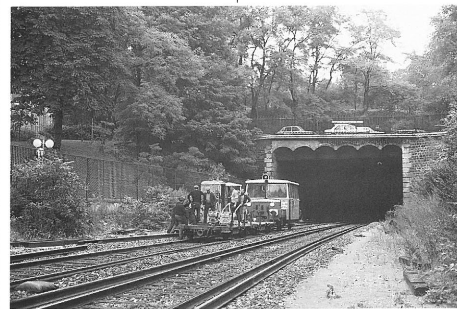
Draisine et wagonnet assurant un train de travaux d'entretien à l'entrée nord du tunnel de Charenton. (Cliché MF Frachot)
